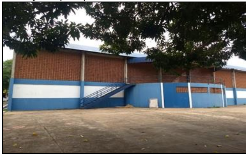
Fotografia 8: Quadra poliesportiva onde os andarilhos fazem de sua moradia
