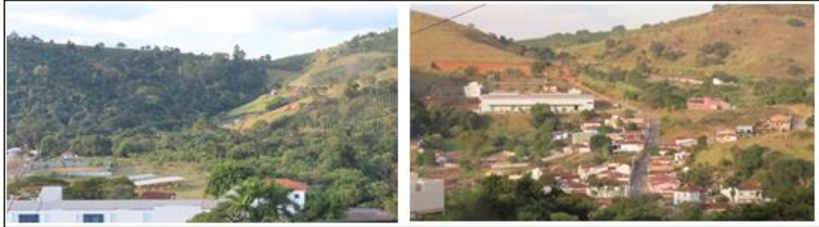
Figura 17: Imagens da Sub-bacia 04 de Machado com destaque para a proteção da mata à esquerda e com a ocupação urbana à direita
