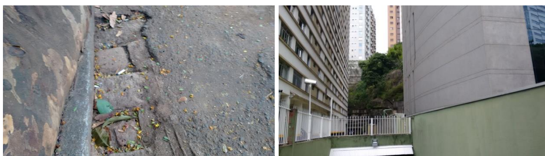
Figura 5. Os estratos da Saracura. Na Rua Dr. Lourenço Granatto, aparecem paralelepípedos de um calçamento antigo, sob o asfalto contemporâneo (fonte: Alessandro de Lima, mar. /2018). Figura 6. A paisagem natural do antigo Vale da Saracura ainda se impõe por trás dos prédios da Avenida 9 de Julho (fonte: Alessandro de Lima, mar./2018).
