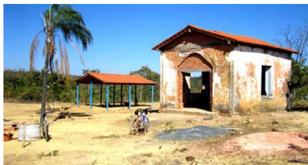
Figura 8: Igrejinha de São Marcos em processo de reforma Foto: site montesclaros.com
