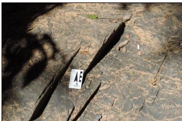
Figura 22 - Aspecto geral de algumas das fraturas encontradas na “Trilha 1”
