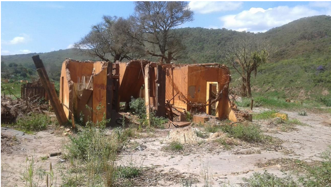
Fotografia 3 – Casa atingida pela lama da Barragem de Fundão
