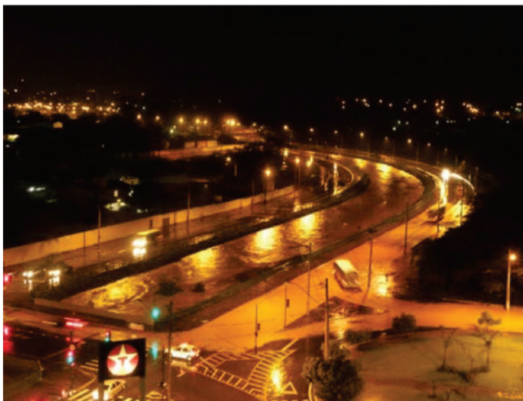
Fotos 1: Inundação do canal principal Rio Vieira e Av. José Correia Machado, Dez/2008.
