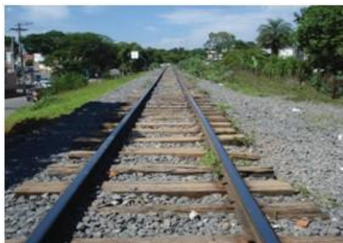
Foto 02 – Atual estrutura das vias permanentes Montes Claros, km 1.116.
