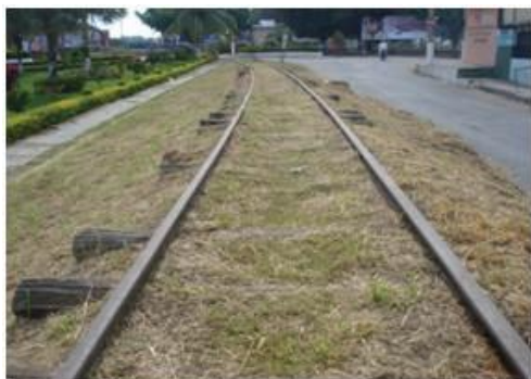
Foto 01 – Antiga estrutura das vias permanentes Pirapora, km 1.006.
