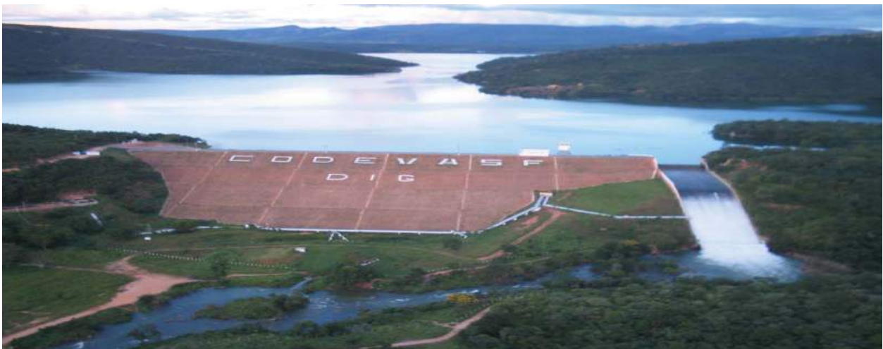
Figura 02: Vista da Barragem Bico da Pedra. Fonte: CODEVASF, 2007.
