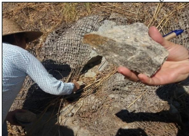
Figura 7 – Talude coberto com manta de sisal e fragmento de granito
