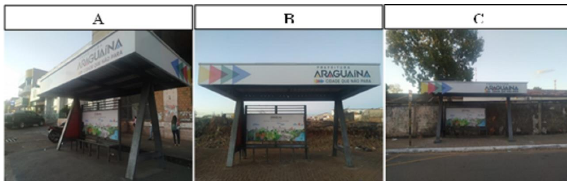
Figura 5 – Registros fotográficos de pontos de ônibus de Araguaína/TO
