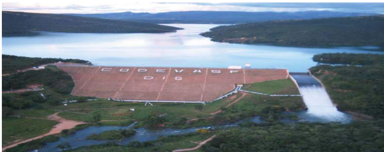
Figura 02: Vista da Barragem Bico da Pedra. Fonte: CODEVASF, 2007.
