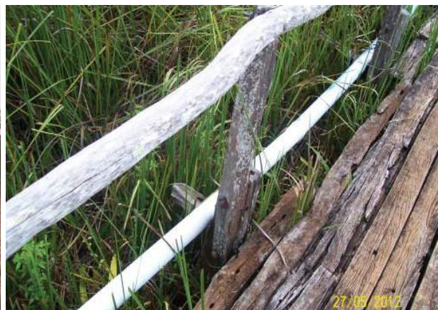
Figura 06: Tubulação na nascente do rio Riachão. Fonte: MOREIRA; SALES; COSTA; BATISTA e MENDES, 2012.
