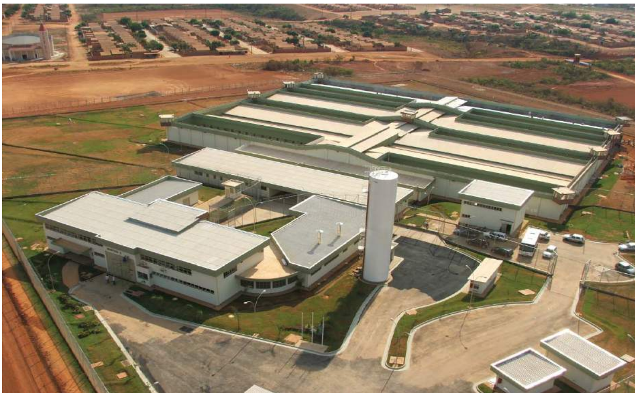
Figura 01: Localização do PRMC na região NE da cidade de Montes Claros – MG. Fonte: Diretoria Operacional. Ano: 2012.
