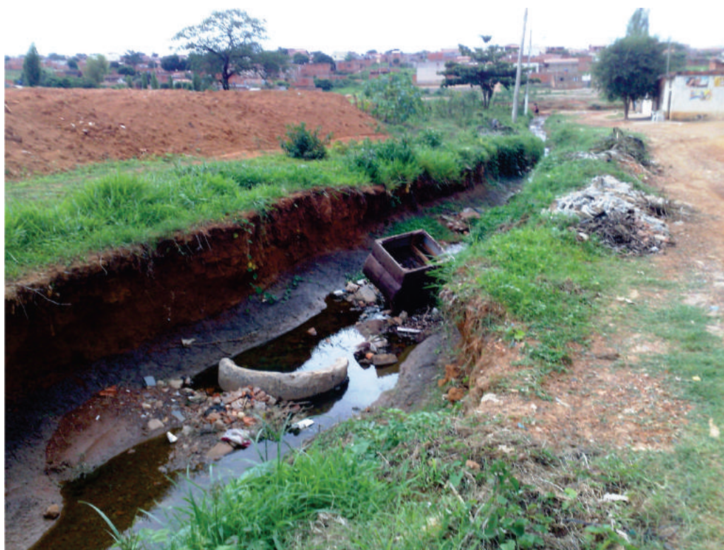
Foto 2: Esgoto e lixo em canal de águas pluviais no bairro São Judas Tadeu
