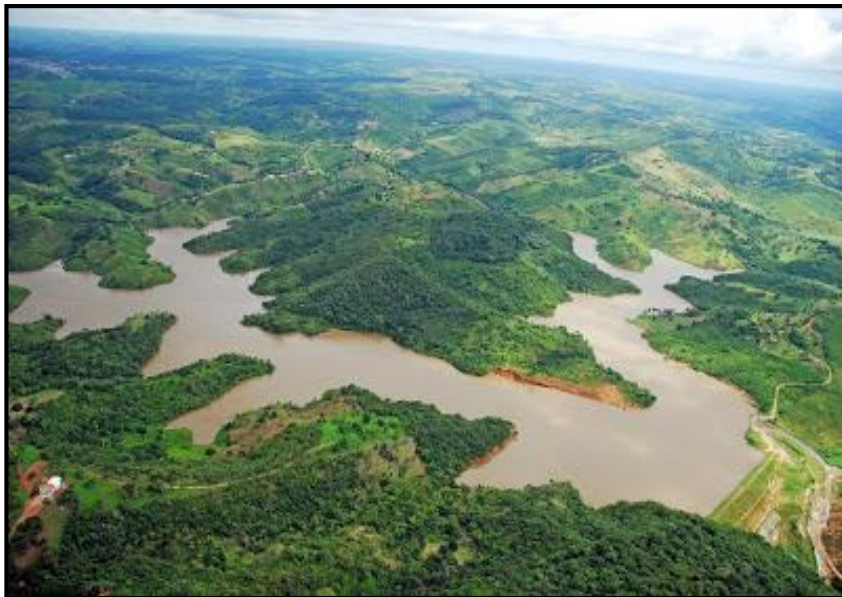
Figura 01 - Vista aérea da Barragem Saulo Maia no município de Areia-PB
