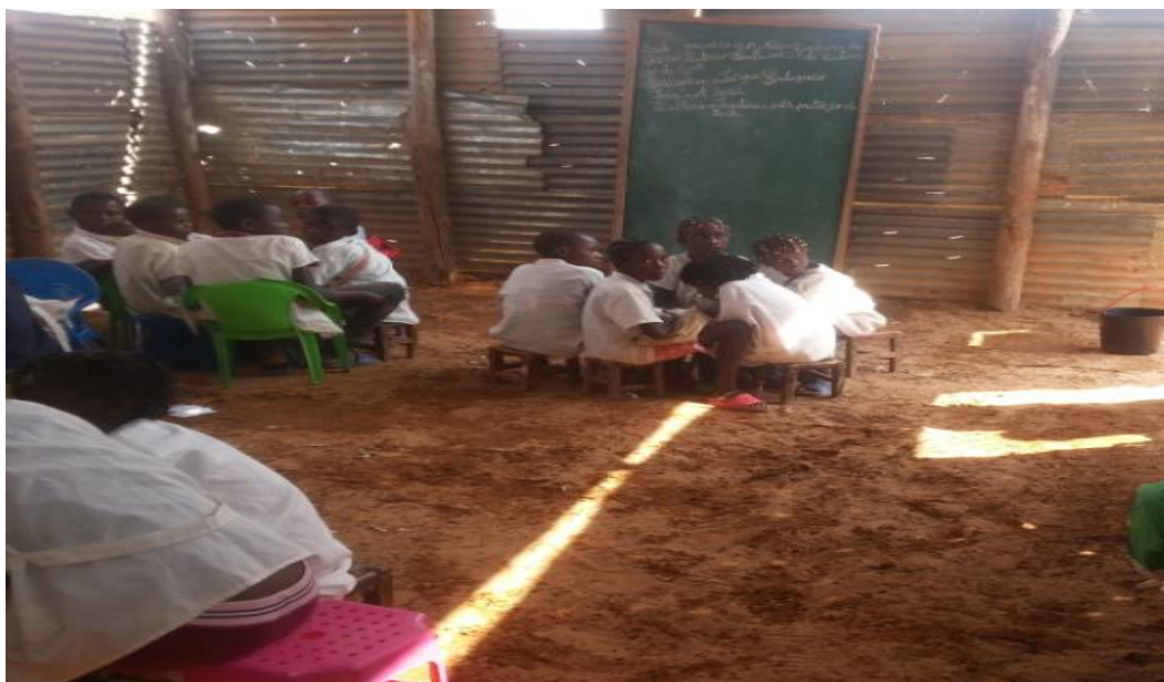
Figura 4 - Condições e sala de aula
