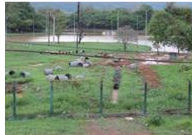
Reconstrução do sistema de drenagem em 2015
