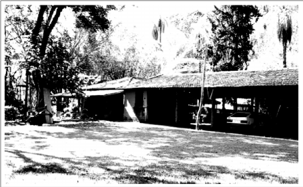
Residência do caseiro e garagem
