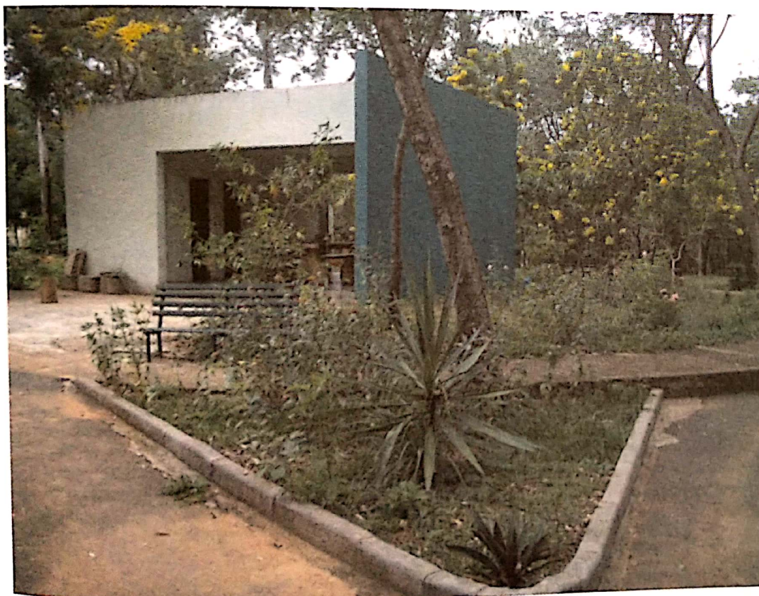
Adaptação de espaços – copa dos funcionários depois da reforma - Foto: Carmem Aguilar
