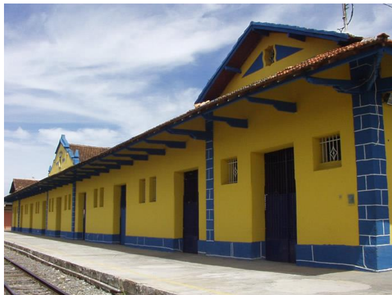
Figura 1: Armazém da Rede Ferroviária
