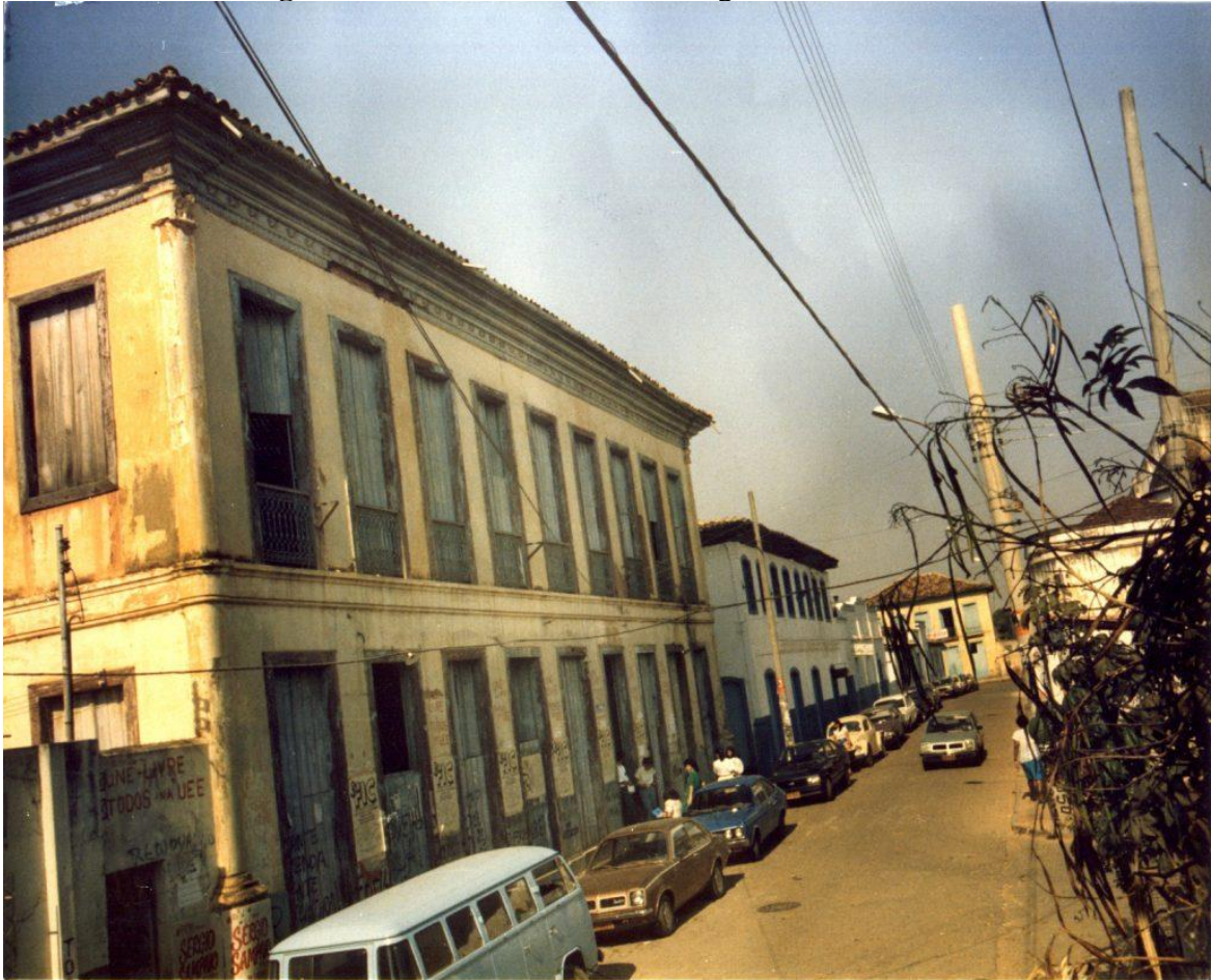
Figura 2 - Vista da fachada do antigo Casarão da FAFIL.
