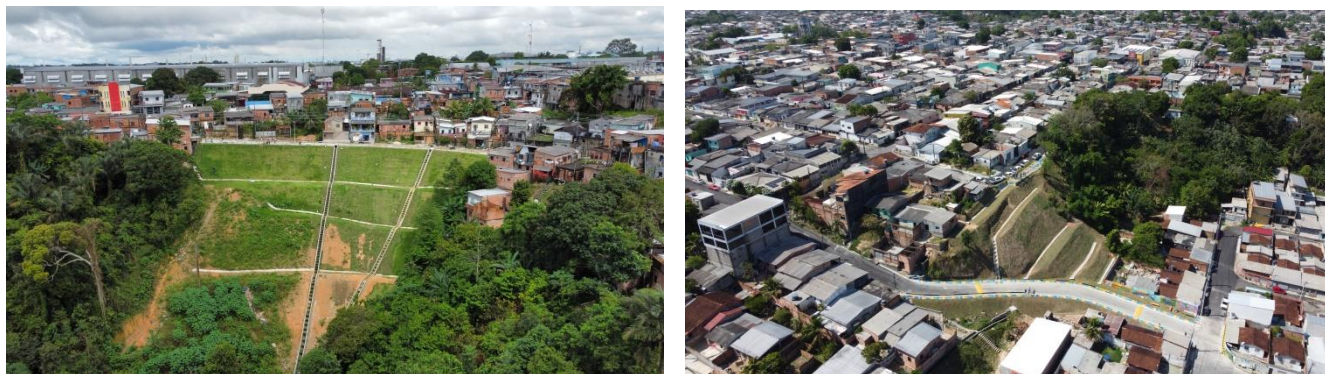
Figura 3 - Intervenções Pontuais: áreas de risco a voçorocamento
