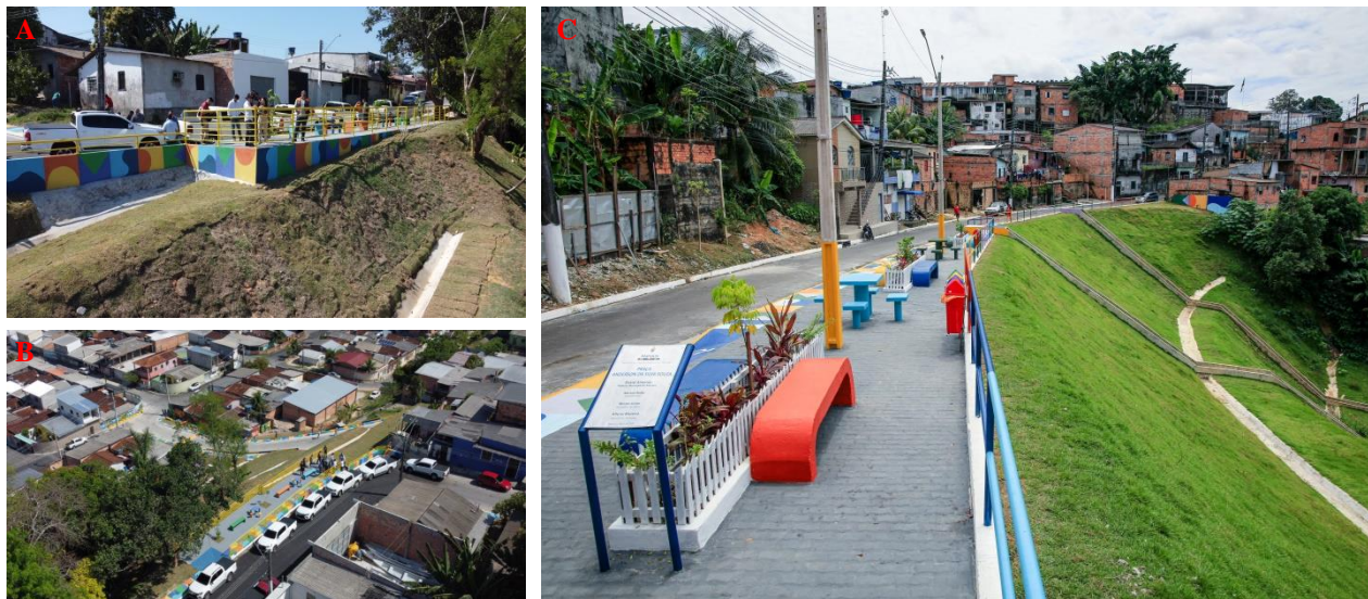
Figura 5 - Espaços de Lazer: revitalização em áreas de risco a voçorocamento em Manaus
