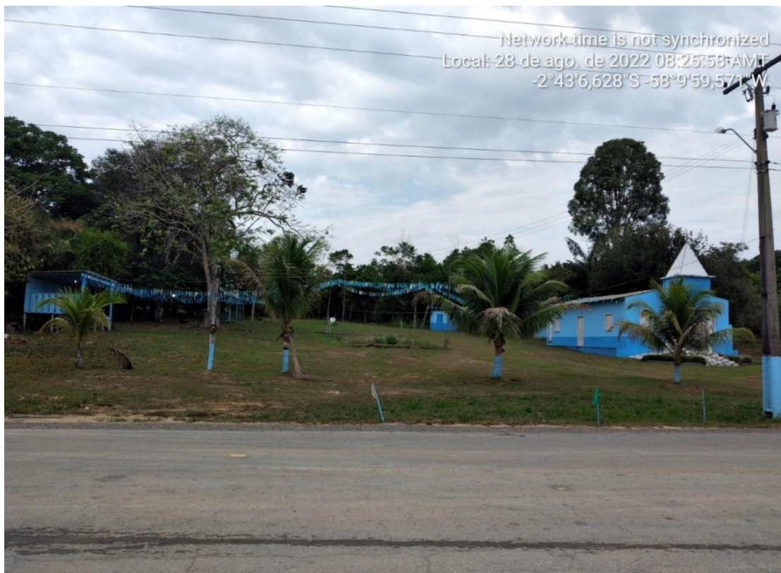
Figura 3 - Comunidade que fica a 10 metros das instalações de um poço para exploração de gás natural.
