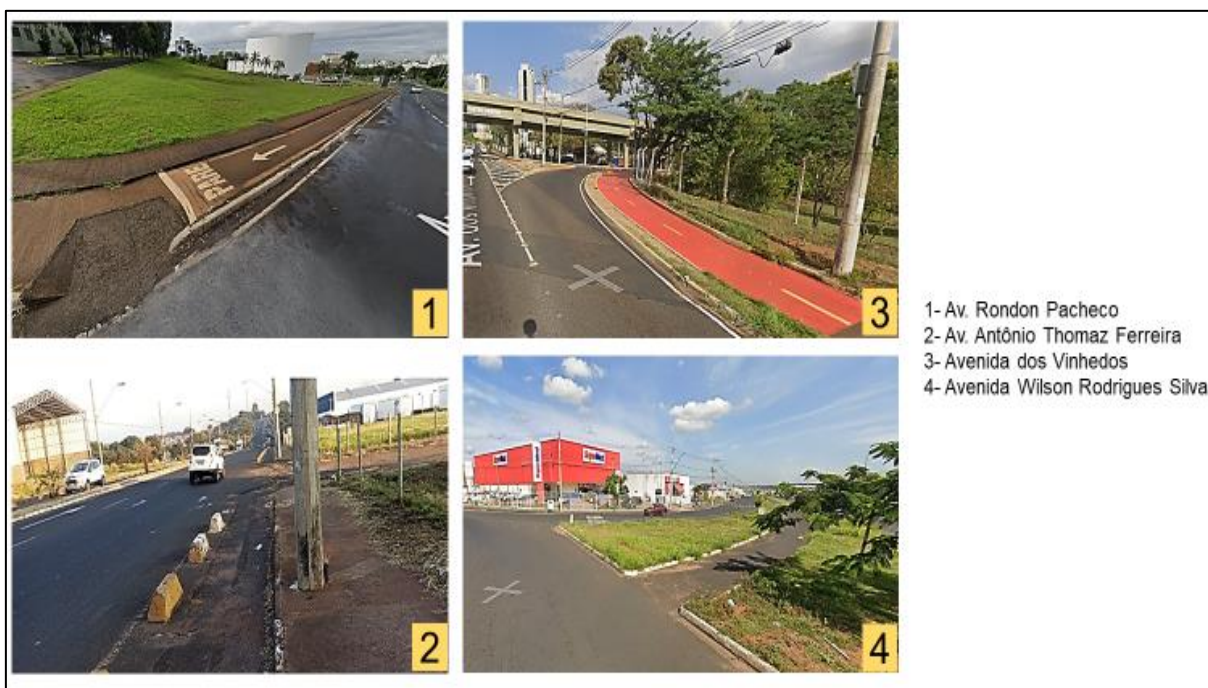
Figura 4 - Condições estruturais das ciclovias e ciclofaixas em Uberlândia (MG)
