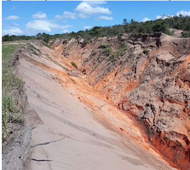
Figura 6: Voçoroca, área rural de Reserva do Cabaçal, MT
